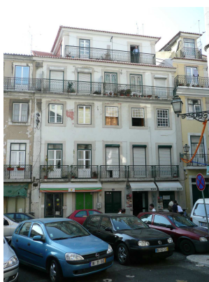
Figura 2.24 – Rua de S. Cristóvão 11-19, edifício Pombalino com aumento posterior de dois pisos (fonte: autor, 2009)
