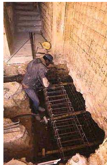
Figura 3.23 – Reforço de fundações (fonte: Alberta Midões, 2002)
