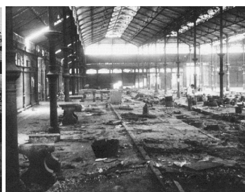
Figura 2.14 - Mercado da Ribeira em demolições (fonte: Arquivo Fotográfico de Lisboa)
