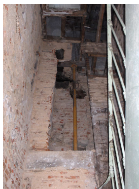
Figura 3.8 – Paredes de alvenaria de tijolo na caixa-de-escada (fonte: EPUL, 2006)
