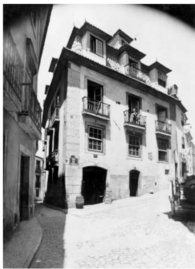
Figura 3.13 - Rua das Farinha 1-3 entre 1898 e 1908 (fonte: Arquivo Fotográfico de Lisboa)
