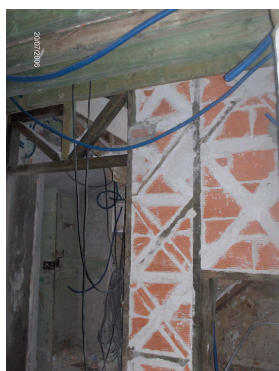
Figura 3.10 – Enchimento das paredes de frontal com tijolo furado (fonte: EPUL, 2007)
