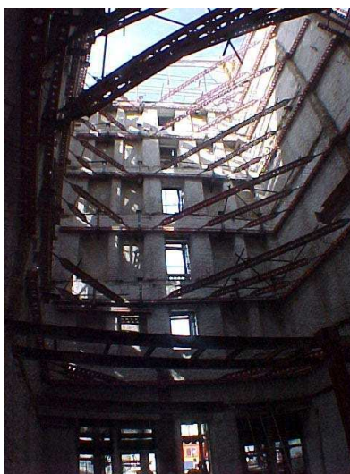
Figura 3.22 – Interior do edifício sem pavimentos (fonte: Alberta Midões, 2002)
