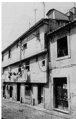
Figura 2.17 - Rua da Guia, 1-7 (fonte: http://www-ext.lnec.pt/LNEC/DED/NA/arq/n tp/vilas/1/1-1.htm , 2009)
