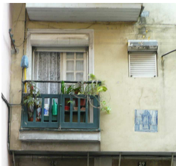
Figura 2.42 – Exemplo de sombreamento a partir de estores exteriores e cortinas interiores de cor clara (fonte: autor, 2009)
