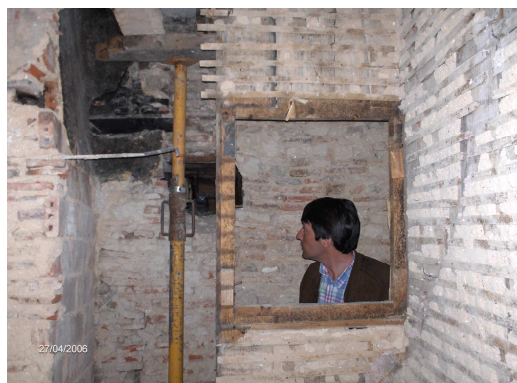
Figura 3.9 – Paredes de tabique (fonte: EPUL, 2006)
