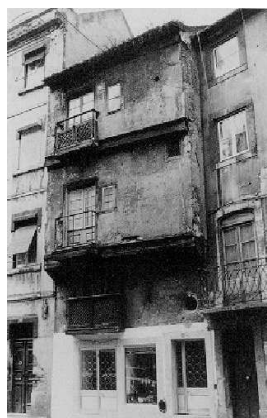
Figura 2.18 - Rua do Benfornoso, 101-103 (fonte: http://www-ext.lnec.pt/LNEC/DED/NA/ar q/ntp/vilas/1/1-1.htm , 2009)
